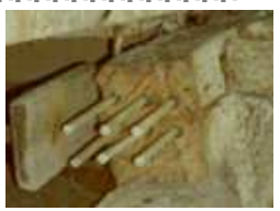
Restauration d'une vieille poutre de charpente
